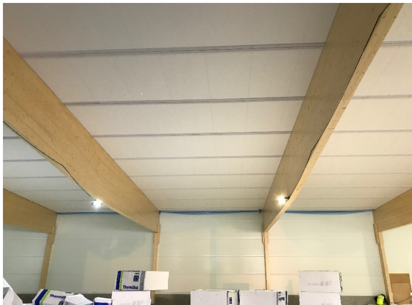
Kuva 27. Liikerakennukset. (Lapwall Oyj)
