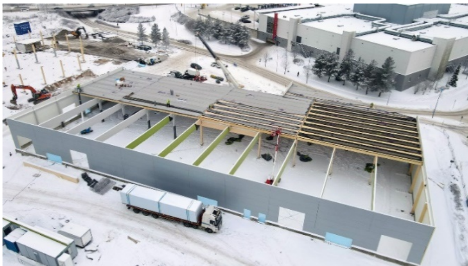
Kuva 34. Kattoelementtien asennus työmaalla. (Lapwall Oyj)
