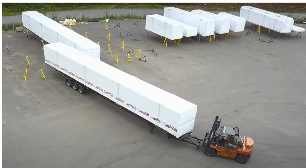
Kuva 33. Kattoelementti tehdas- ja työmaavarastointuna. (Lapwall Oyj)
