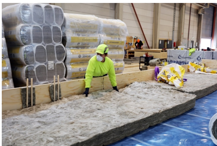
Kuva 30. Lämmöneristeen asennus kattoelementin sisälle. (Lapwall Oyj)
