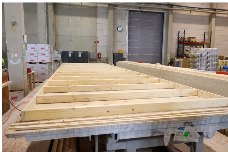
Kuva 29. Kattoelementin alapinnan koolaus. (Lapwall Oyj)
