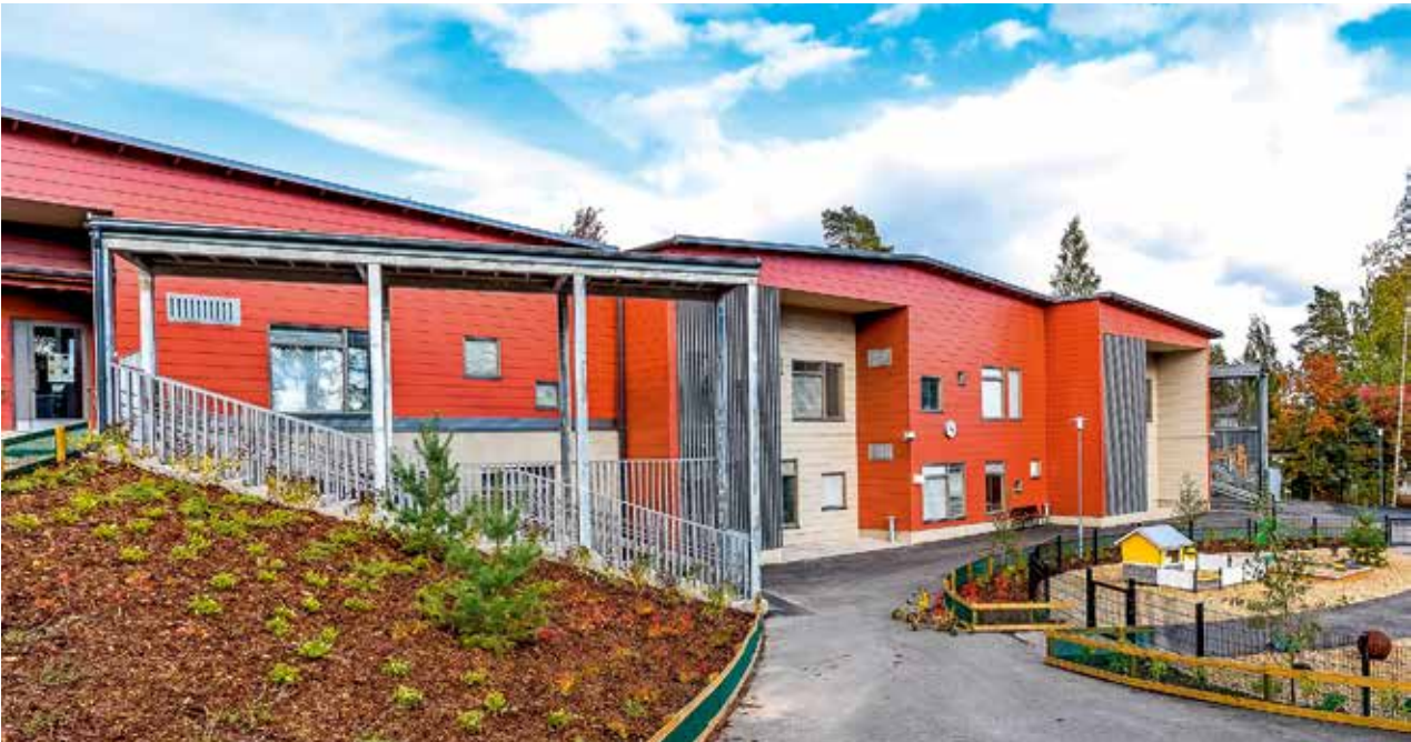
Yleisin toteutusmuoto pienemmissä julkisissa puukohteissa on kokonaisurakka, mutta suuremmissa kohteissa on yleistynyt suunnittelun ja rakentamisen sisältävät toteutusmuodot. KVR-hankkeena toteutui myös Koivukylän hirsipäiväkoti. Fixed-price contracts seem to be the most common model in smaller public projects. However, models that also include design and construction have become more widespread in larger projects. The log daycare centre in Koivukylä was also built as a turnkey project.
