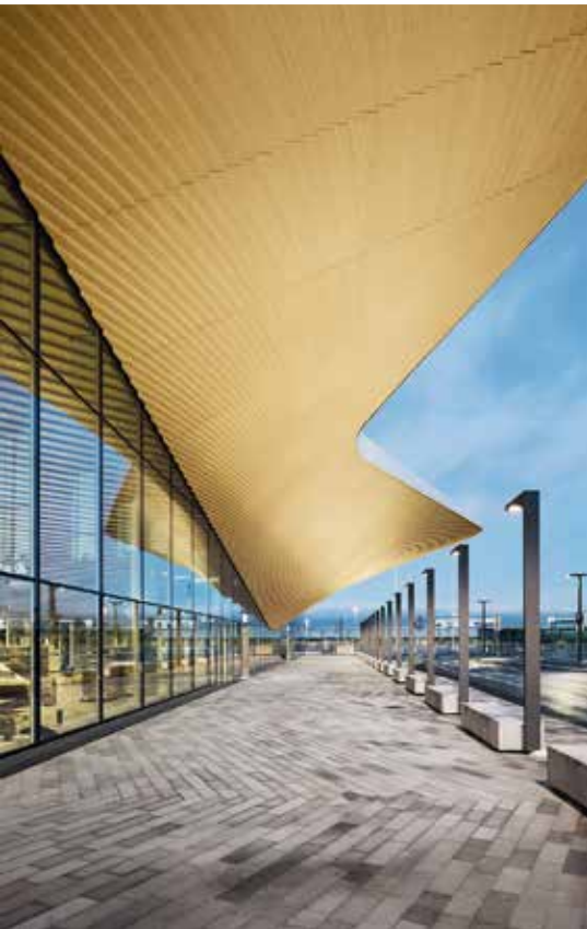
Jokainen alakattoelementti on yksilöllinen. Elementtien syysuunnat on huolella sovitettu katon geometriaan. | Each element of the wooden ceiling is unique. Wood grain has been matched with care to the geometry of the roof.
