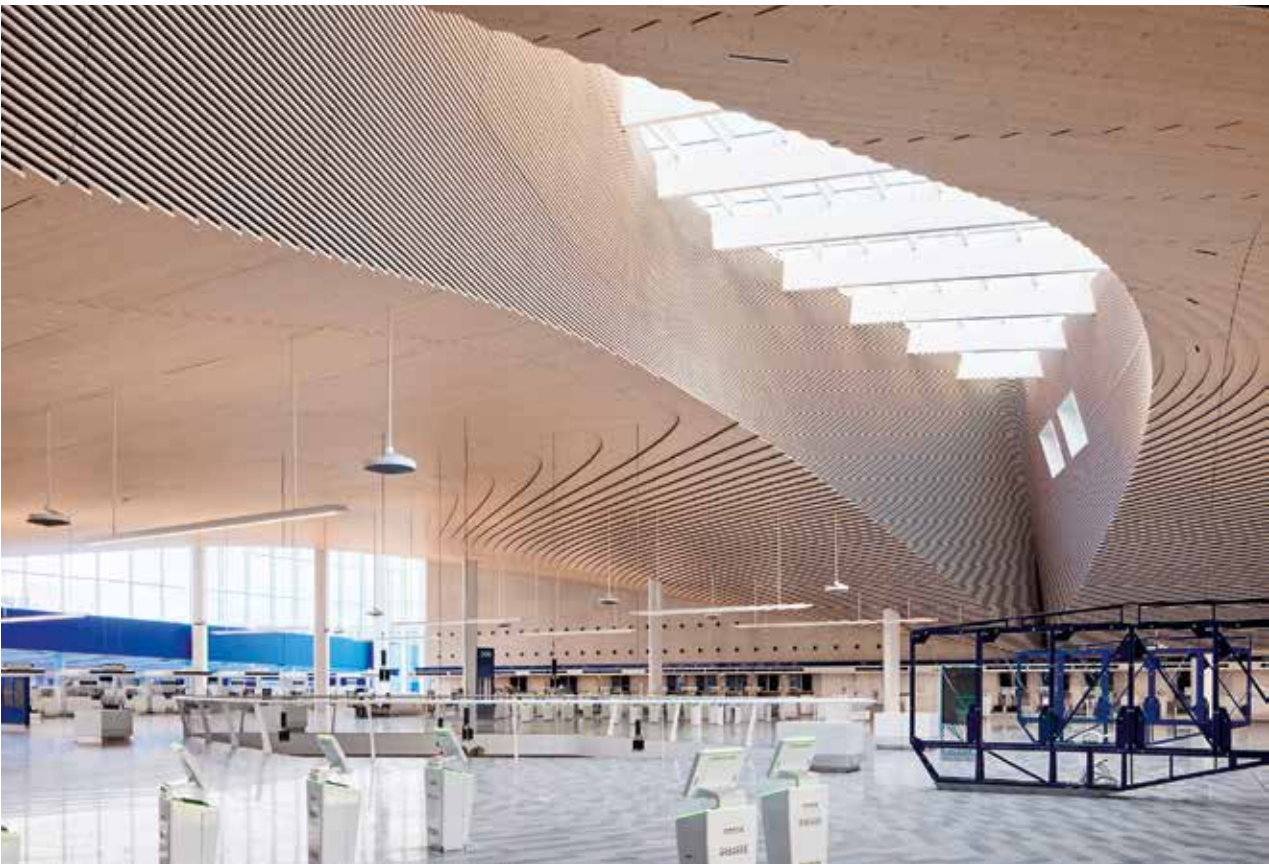
Puualakaton vapaamuotoiset, näkyvät pinnat muodostuvat vaakasuuntaisista, osin päällekkäin limittyvistä paneeleista. | The free-form surfaces visible to travellers are created from horizontal, partially overlapping panels.
