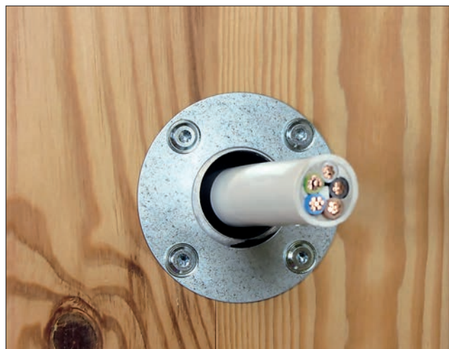
Kuva 54. Kaapeliläpivienti puurakenteessa (palomansetti). Kuva: Sewatek
