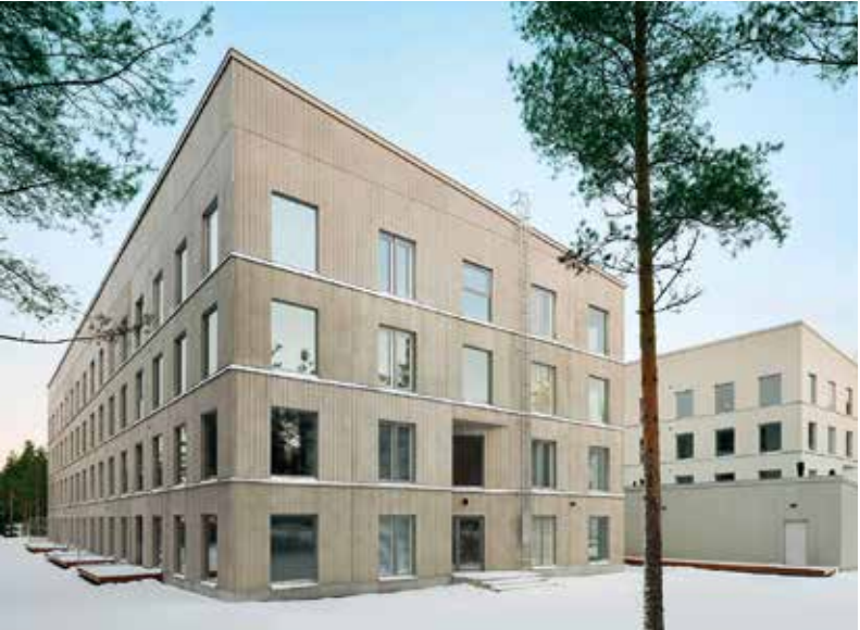
Kohteessa toteutettiin kaksi täysin samanlaista rakennusta; toinen betonista ja toinen puusta. | Two completely identical buildings were built on the site; one of concrete and the other of wood.
