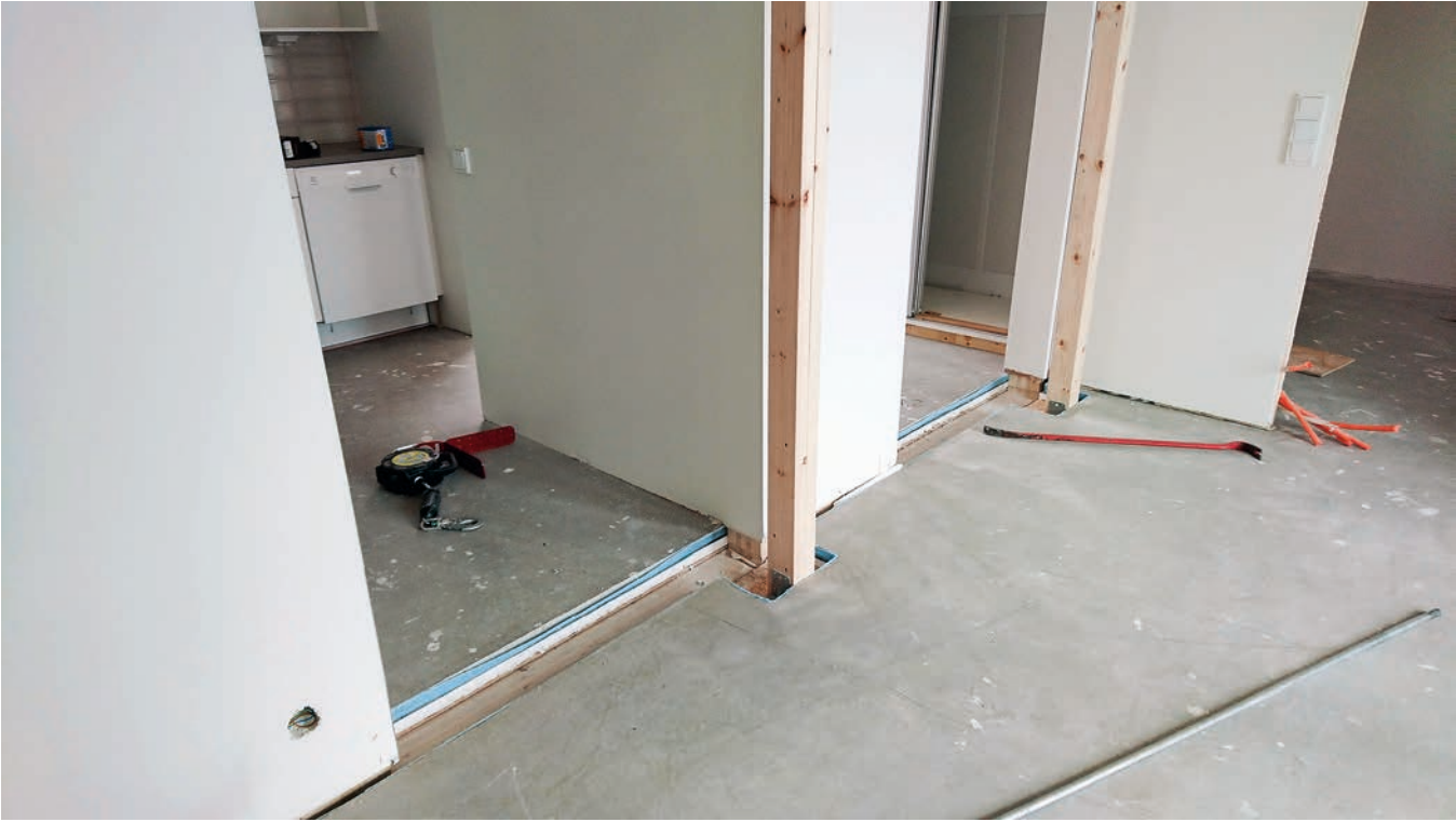
Kuva 8. Kahden elementin välinen liitos asennuksen jälkeen.
