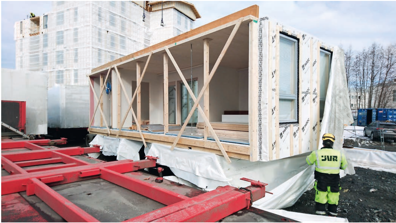
Kuva 4. Yhdeltä puoleltaan avoimen elementin väliaikainen tuenta.
