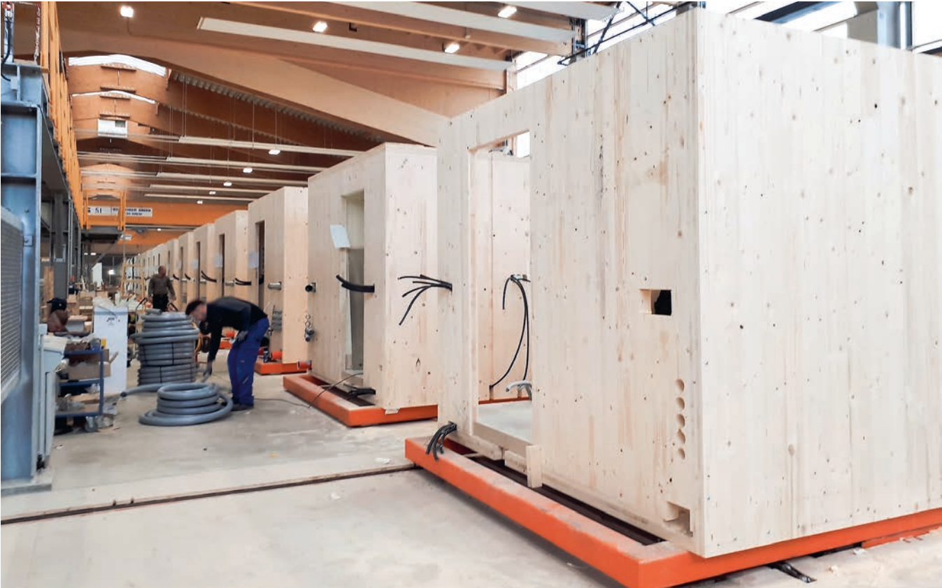
Kuva 8. CLT-runkoisia tilaelementtejä valmistetaan suureen opiskelija-asuntolakohteeseen Itävallassa.
