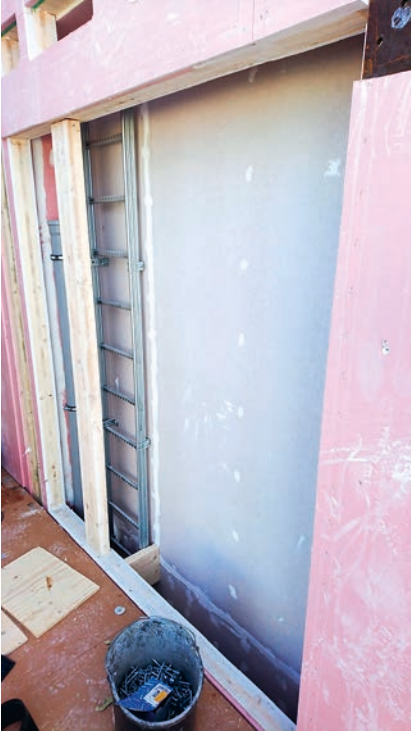
Kuva 10. Tyhjä tekniikkakuilun varaus työmaalla.
