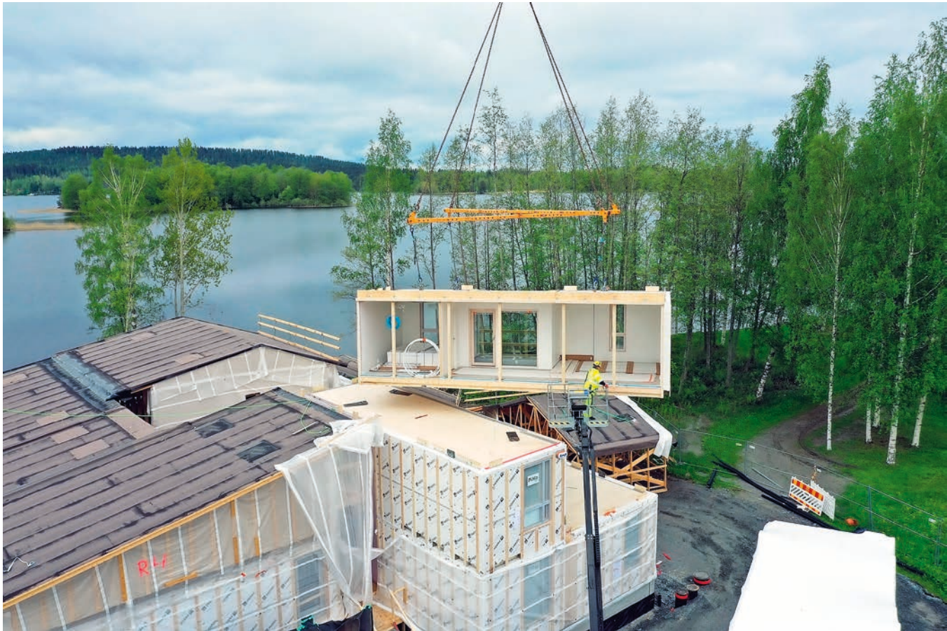
Kuva 3. Nosturin paikkaa valittaessa on huomioitava nostoetäisyydet sekä elementtien varastointi nosturin nostoetäisyydelle.
