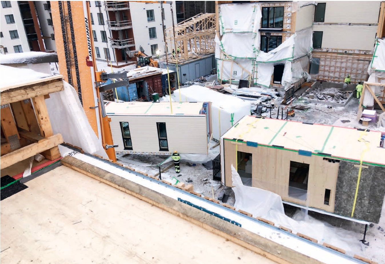
Kuva 3. Elementin nostaminen liinanostona.
