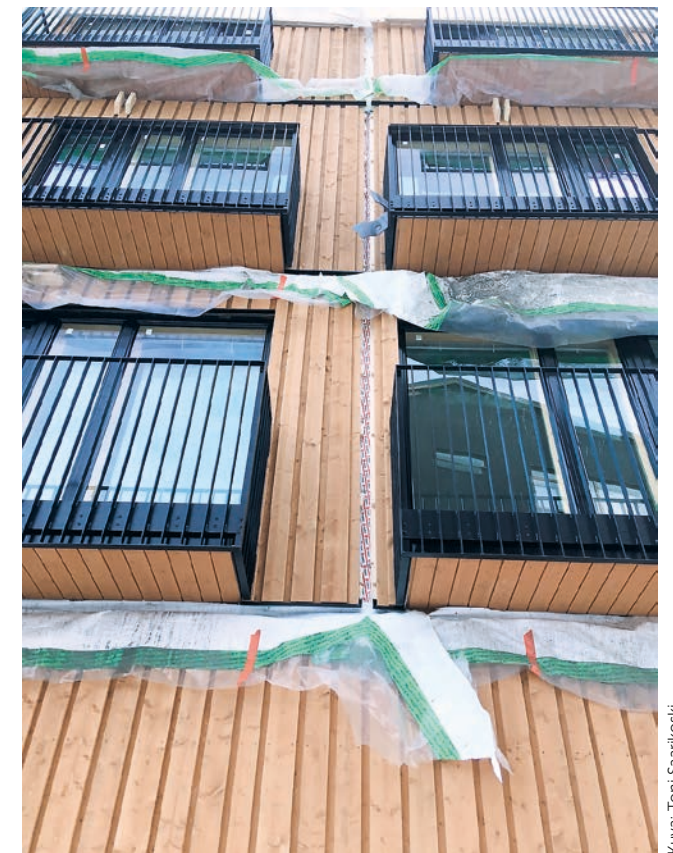
Kuva 1. Lumipuun julkisivun elementtien väliset vaak- ja pystysaumot viimeisteltiin työmaalla.
