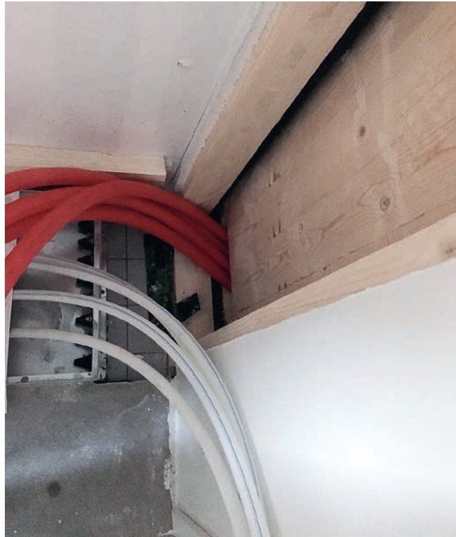
Kuva 5. Putkien ujutus viereiseen elementtiin.
