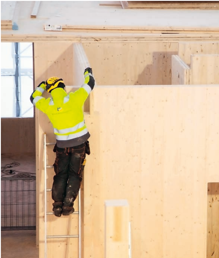
Kuva 32. Kun massiivipuoratkaisut on hyvin suunniteltuja, ne ovat millintarkkoja työmaalle asti.
