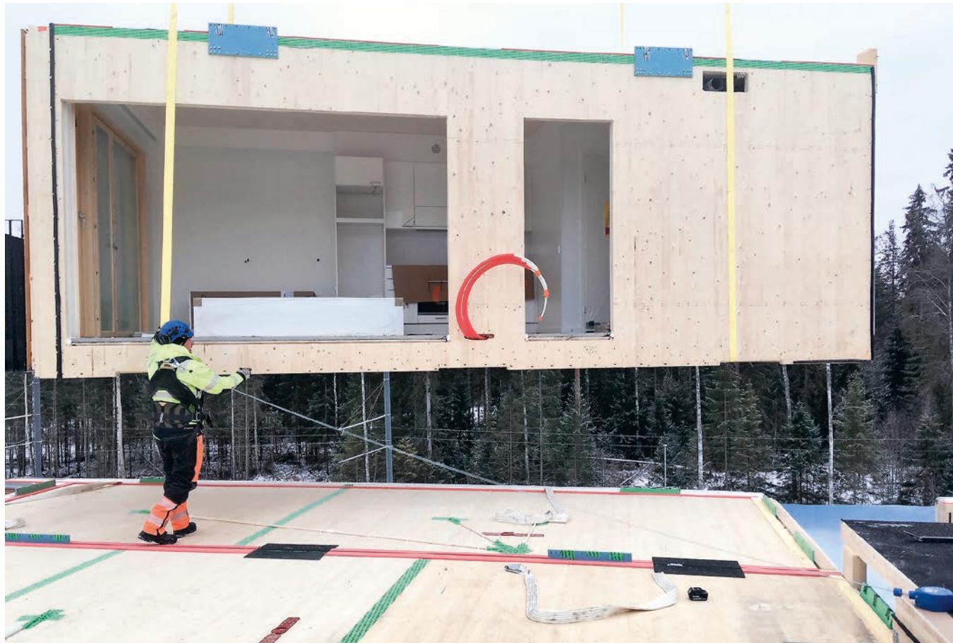
Kuva 7. Kahdesta moduulista koostuvan asunnon kytkettävät tekniikat.
