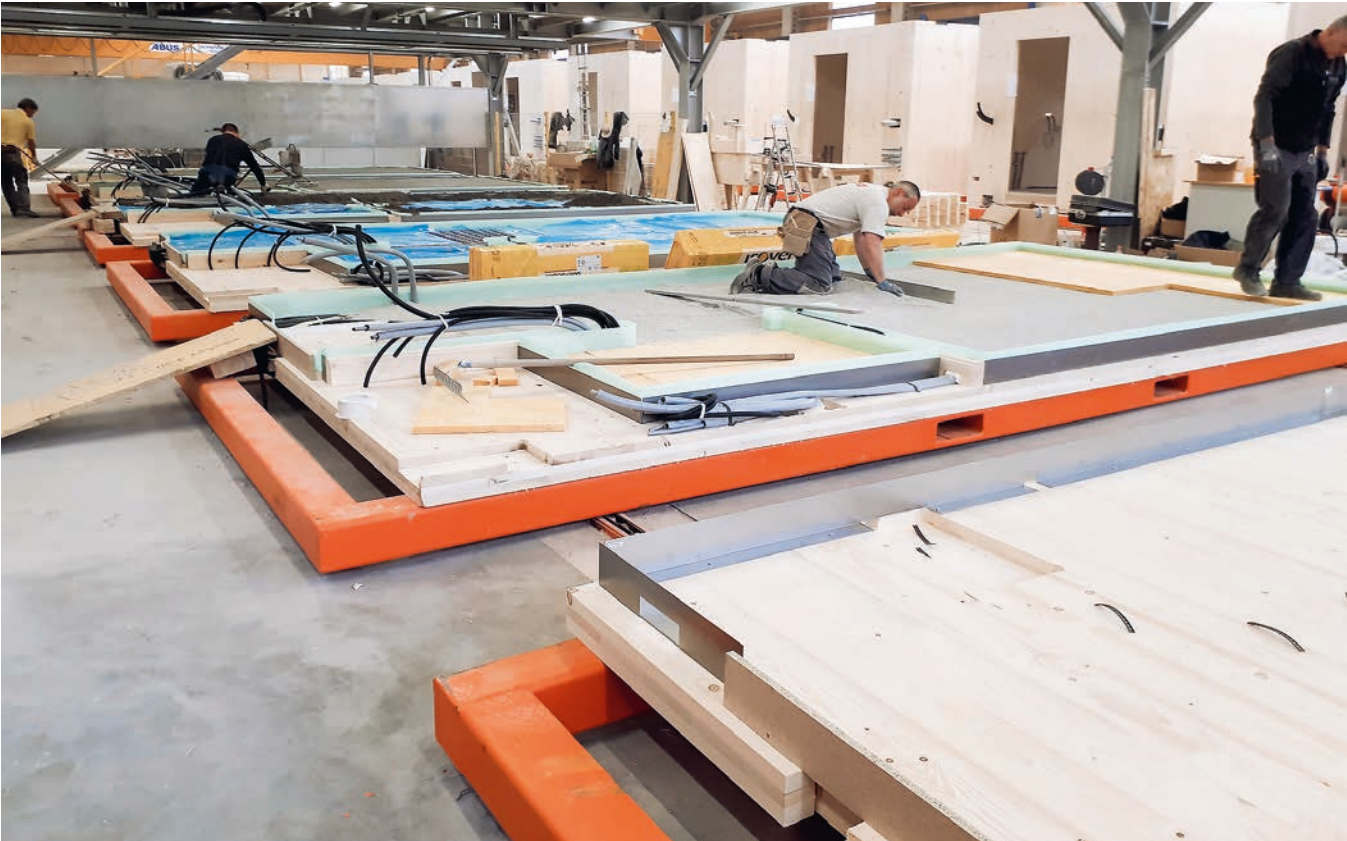
Kuva 9. Tilaelementtien lattiatasojen tekoa Itävallassa.
