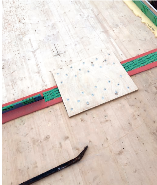
Kuva 6. Kahden elementin välinen vaneriliitos elementtien katolla.
