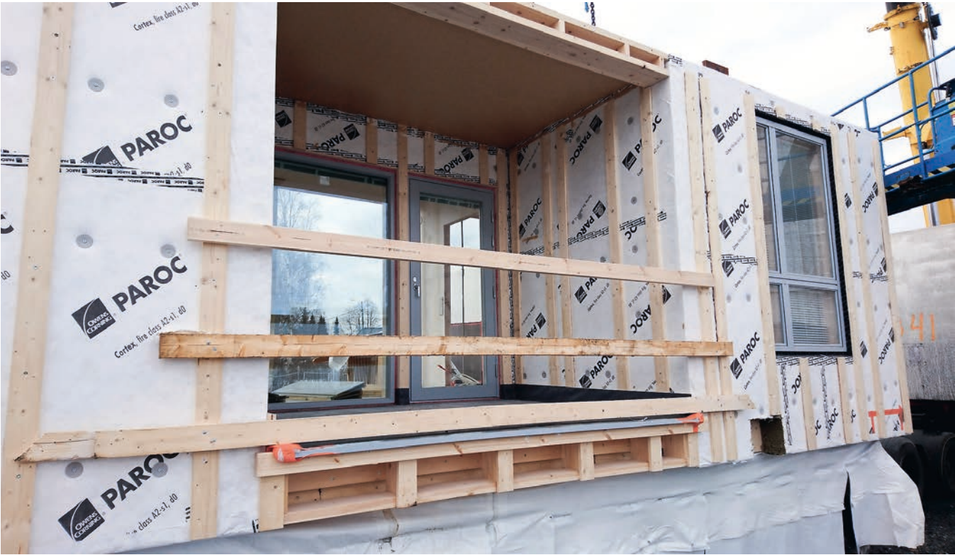
Kuva 14. Työnaikainen putoamissuojaus kiinnitettyä parvekkeelle.
