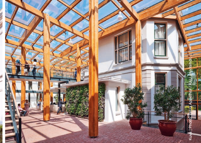
Brummenin kaupungintalon teollisesti valmistettu puinen runkorakenne on suunniteltu purettavaksi, ja helposti avattavat liitokset on jätetty näkyviin. | Brummen City Hall's pre-fabricated wooden frame is designed for future dismantling. Its easy-to-open joints are left in plain sight.
