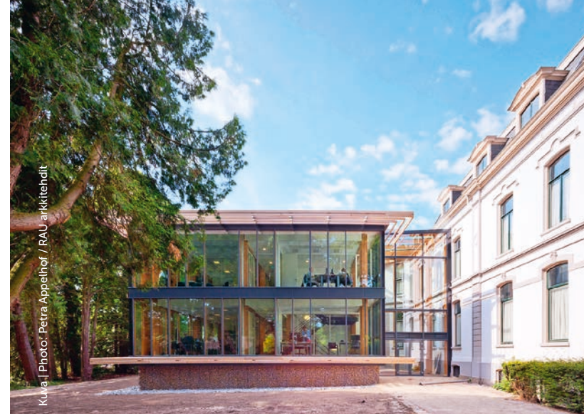
Brummenin kaupungintalon laajennus, joka on suunniteltu purku ja kierrätys mielessä pitäen. Alankomaat, 2013. | An extension to Brummen City Hall, designed with dismantling and recycling in mind. The Netherlands, 2013.
