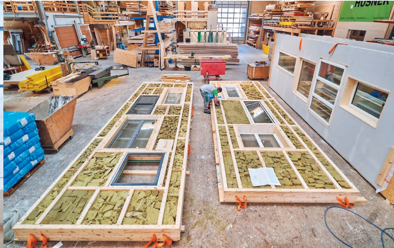
Sveitsin Baselissa sijaitseva ELYS-kauppa- ja kulttuuritalo on malliesimerkki kiertotalouden mukaisesta rakentamisesta. Rakennuksen uudet julkisivuelementit valmistettiin tehtaalla kierrätysmateriaaleista. | The ELYS cultural and commercial building in Basel, Switzerland, is a model example of applying the principles of circular economy to construction. New facade elements of the building were built at the factory from recycled materials.
