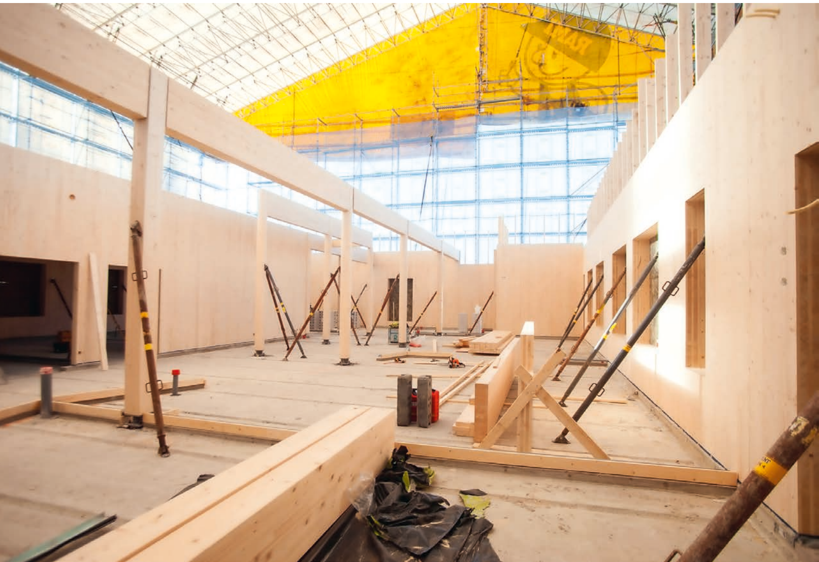
Rakennuselementtien teollinen esivalmistus vähentää jätteitä, nopeuttaa rakentamista ja parantaa rakentamisen laatua. | Industrial prefabrication of building elements reduces waste, speeds up construction and improves construction quality.
