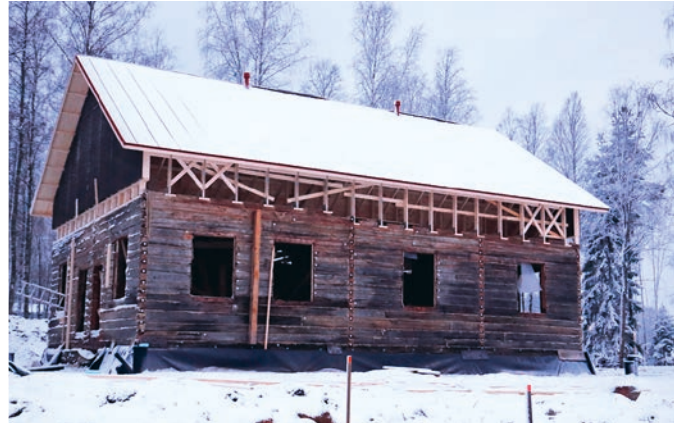
Talo siirrettynä ja katto päällä vuoden 2021 joulukuussa | The house once it was moved and had a roof put on in December 2021
