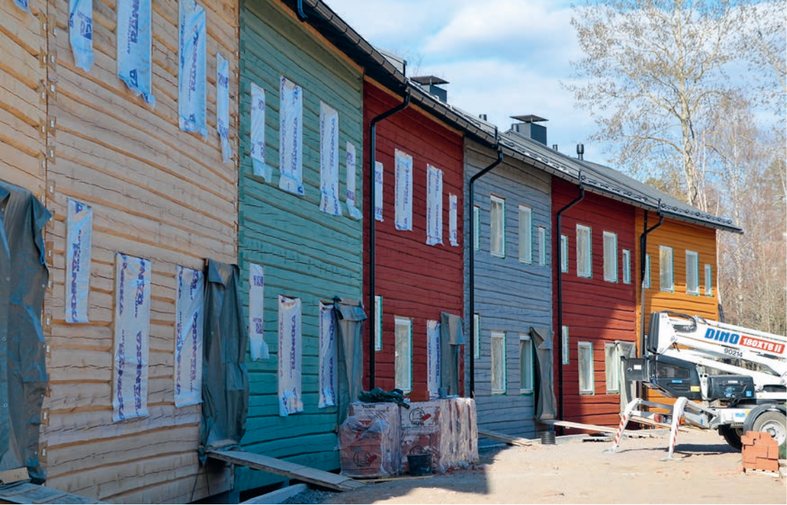
Asuntojen julkisivut ovat asemakaavamääräyksen mukaisesti keskenään eriväriset. Pintakäsittely on tehty erivärisillä keittomaaleilla. | As required by the municipal zoning plan, each unit's facade is a different colour. The surfaces have been treated with ochre paints in various shades.
