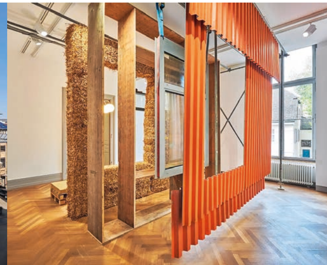
K118-hankkeen ulkoseinärakenne: kierrätetty pelti, kierrätetyt ikkunat, puurunko, olkieriste ja savirappaus. | K118 exterior wall structure: recycled sheet metal, recycled windows, wooden frame, straw insulation and clay plaster.
