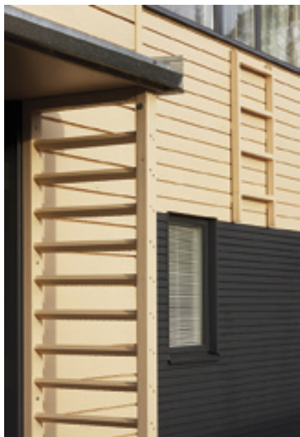
Julkisivut ovat valmiiksi maalattua, hienosahattua Colorwood-vaakapaneelia.
