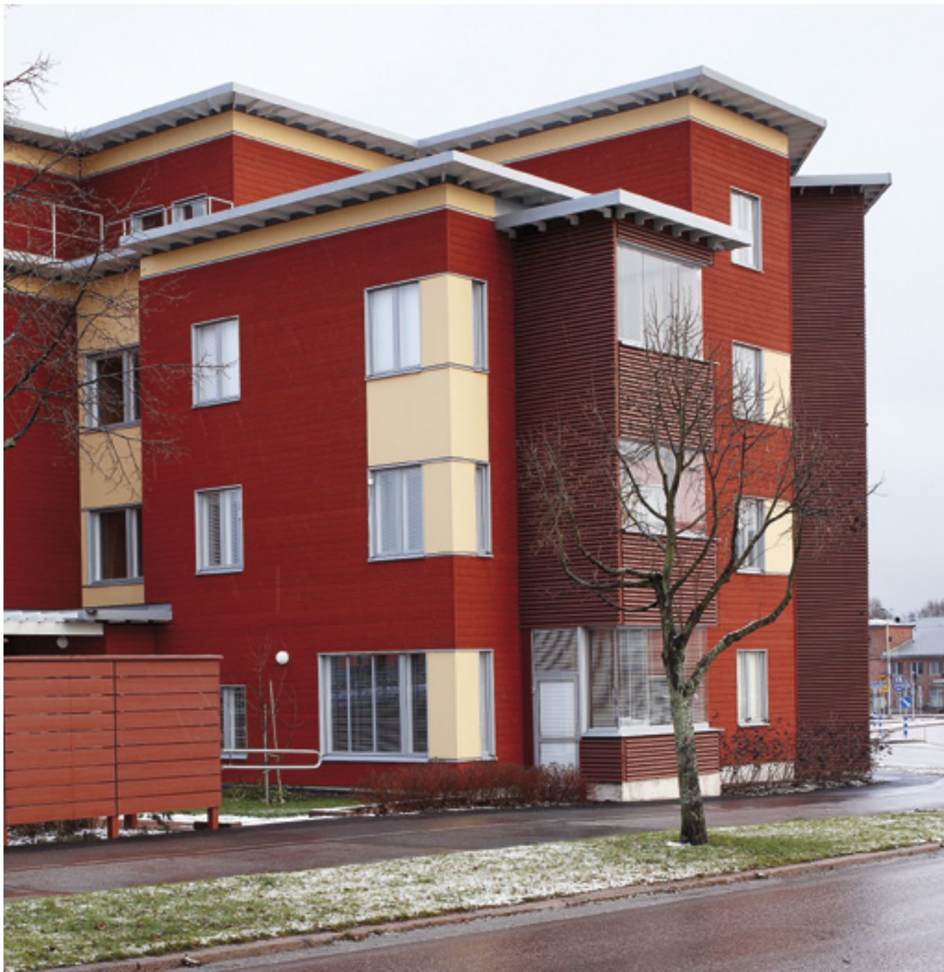
Nelikerroksinen asuinrakennus kuuluu Mauno Eerikinpojankadun puulla verhottujen kerrostalojen rivistöön. Rakennusrunkoa täydentävät parvekkeet, joiden liimapuurakenteet ovat neljän kerroksen korkuisia.
