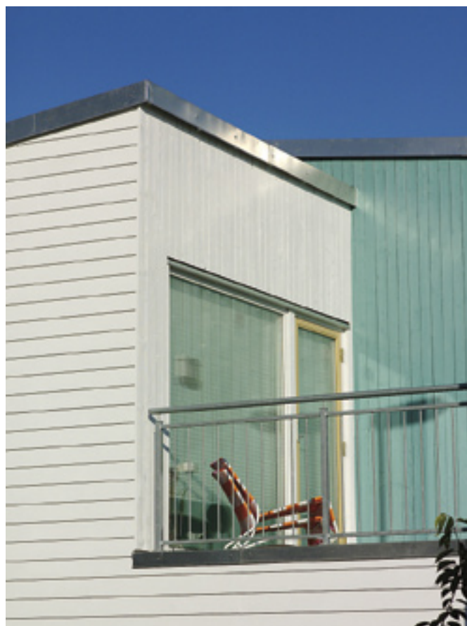
Ulkoseinät on verhottu pysty- ja vaakasuuntaan asennetulla limilau-doituksella.
