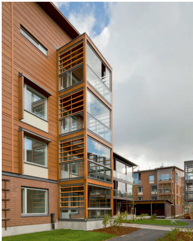
Liimapuusta halkaistu 42 millimetriä paksu julkisivupaneeli on pisimmillään 12 metriä pitkä. The split glulam exterior cladding panel is 42 mm thick and 12 metres long at its longest.
