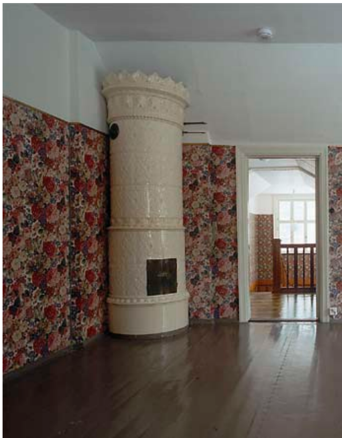
Yläkerran toimistohuoneen pionitapetti puhdistettiin ja irronneet osat liimattiin.
