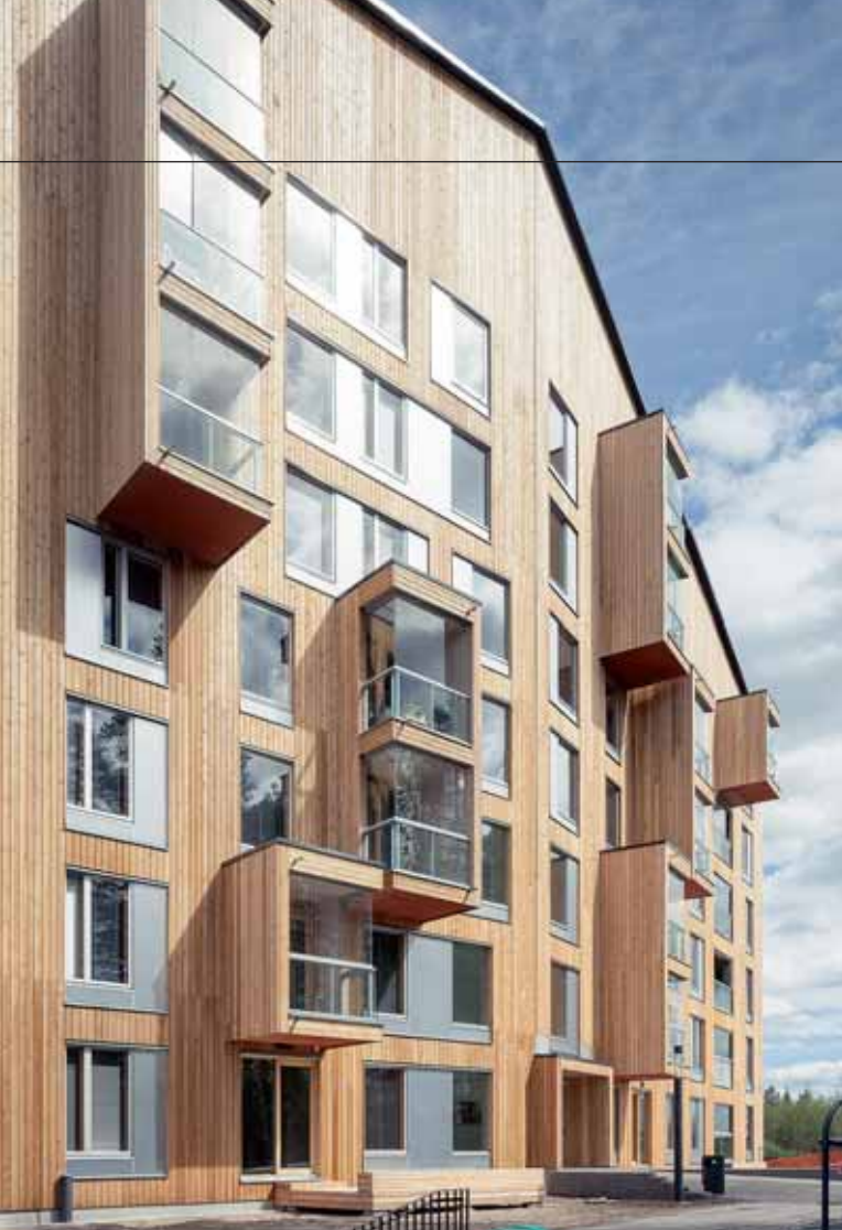
NT palosuoja-ainetta on käytetty Jyväskylän Puukuokan ulkoverhousutuotteissa. NT fire retardant was used in exterior cladding products in the Puukuokka building in Jyväskylä.
