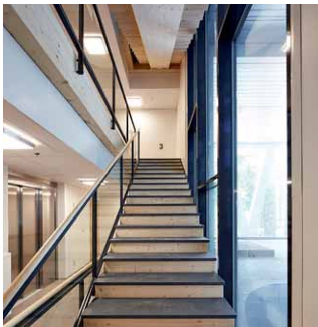
Kivistön Puumeran rappukäytävän puupinnat on NT palosuojattu. In the Puumera wooden multi-storey building in Kivistö, the wooden surfaces in the staircase were fire protected with NT fire retardant.
