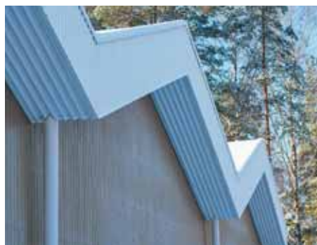
Reilut ja helposti toteutettavat koteloräystäät suojaavat puuverhottuja julkisivuja. Wide and easily implemented box-type eaves protect the wood-clad facades.
