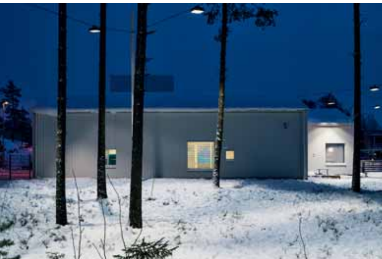
Osa piha-alueesta säilytettiin luonnontilaisena. Part of the yard area was left in a natural state.
