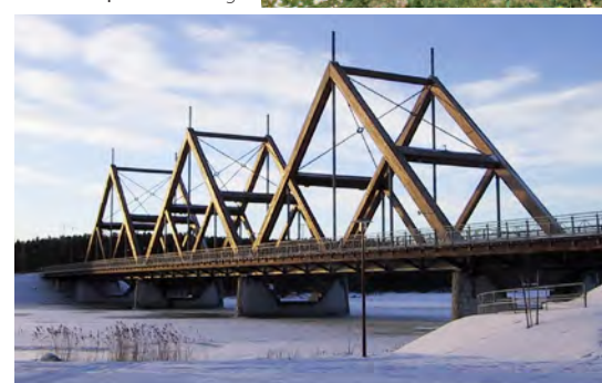
Liittorakennesilta | Crossed-stressed bridge
