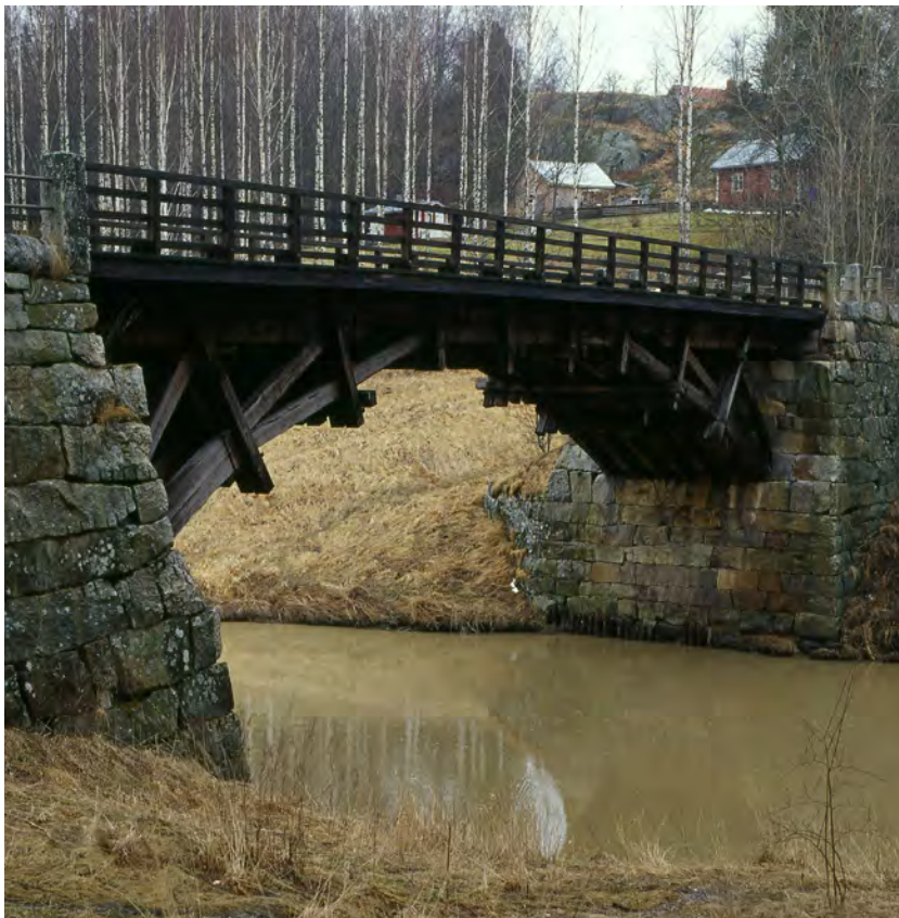
Halikonjoen vanha silta, joka rakennettiin vuonna 1866 puuta ja kiveä hyödyntäen. Silta on edelleen kevyen liikenteen käytössä. | The old bridge over Halikonjoki River was built in 1866 using a combination of wood and stone. It is still used to carry lightweight traffic, such as bicycles.
