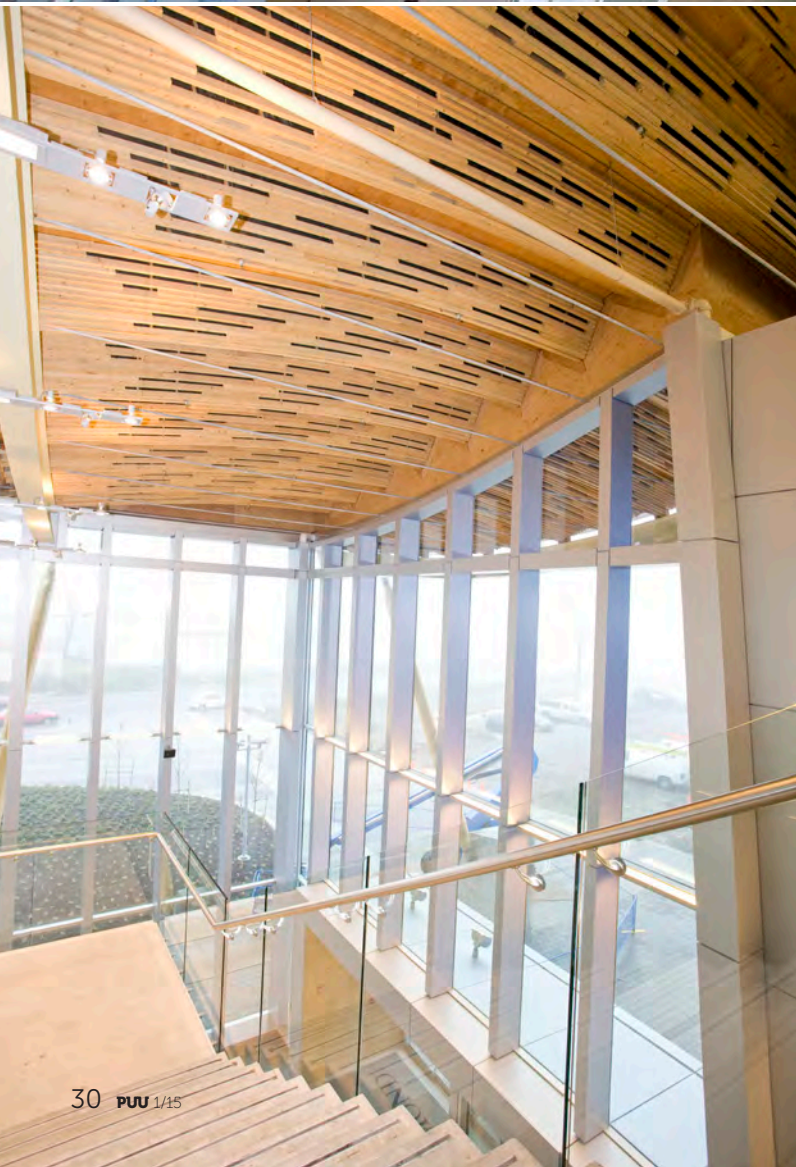
Pääkannattajien liittyminen jalkarakenteeseen on siro. | Slender connection between main beams and supports.
