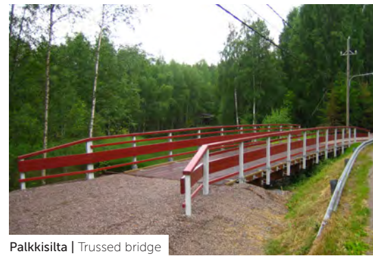
Palkkisilta | Trussed bridge
