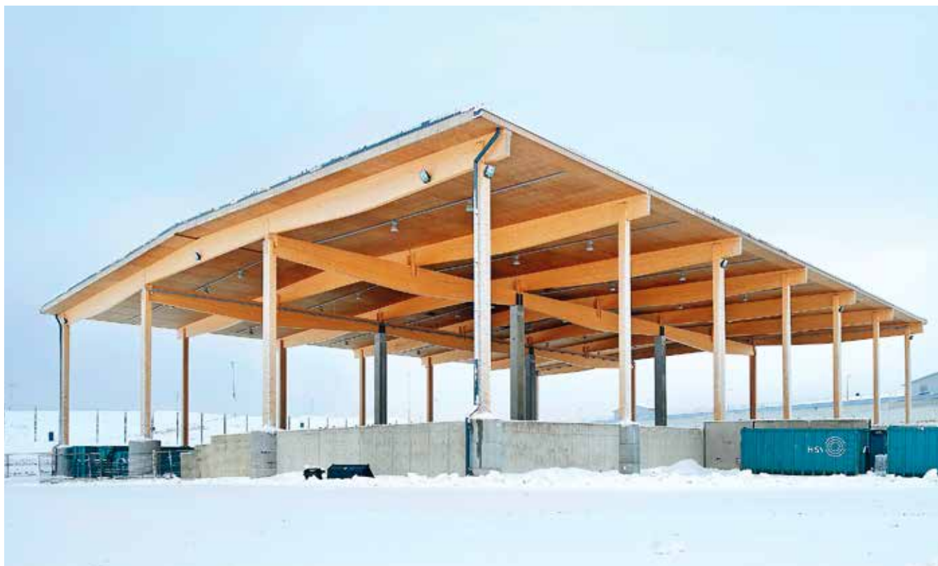
Ämmässuon jätteidenkäsittelylaitoksen katosta kantavat mastojäykistetyt pilarit ja niiden varaan kiinnitetyt maha- ja harjapalkit.
